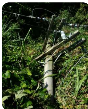
Curuzu – Poste Tombado
