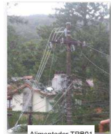
Alimentador TRB01 15/01/2018 Causa: Queda de árvore
