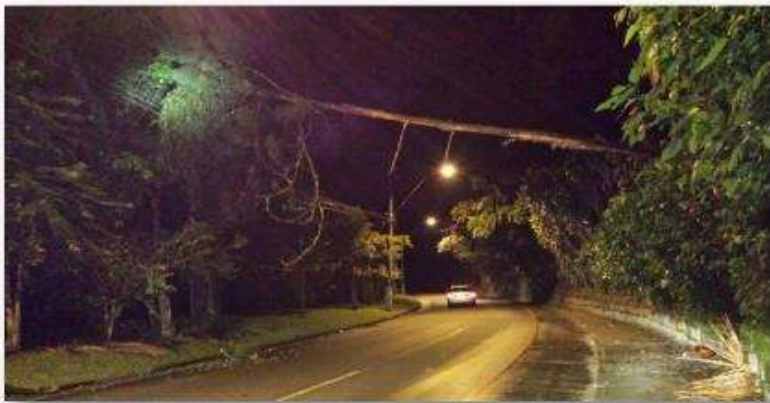
Alimentador ITA06 – 15/01/2018 Causa: Queda de árvore
