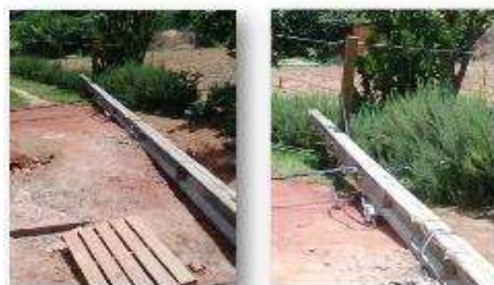
Alimentador TER04 – 17/01/2018 Causa: Solo instável, fortes chuvas
